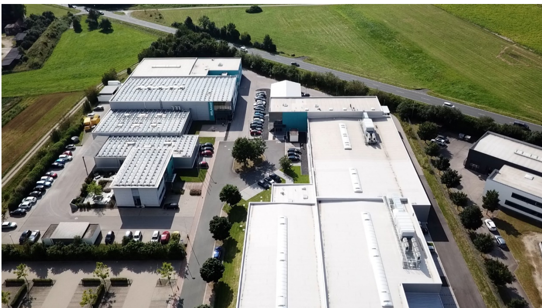
Fertiggestellter Erweiterungsbau (u. r.) von WILAméd aus der Vogelperspektive
